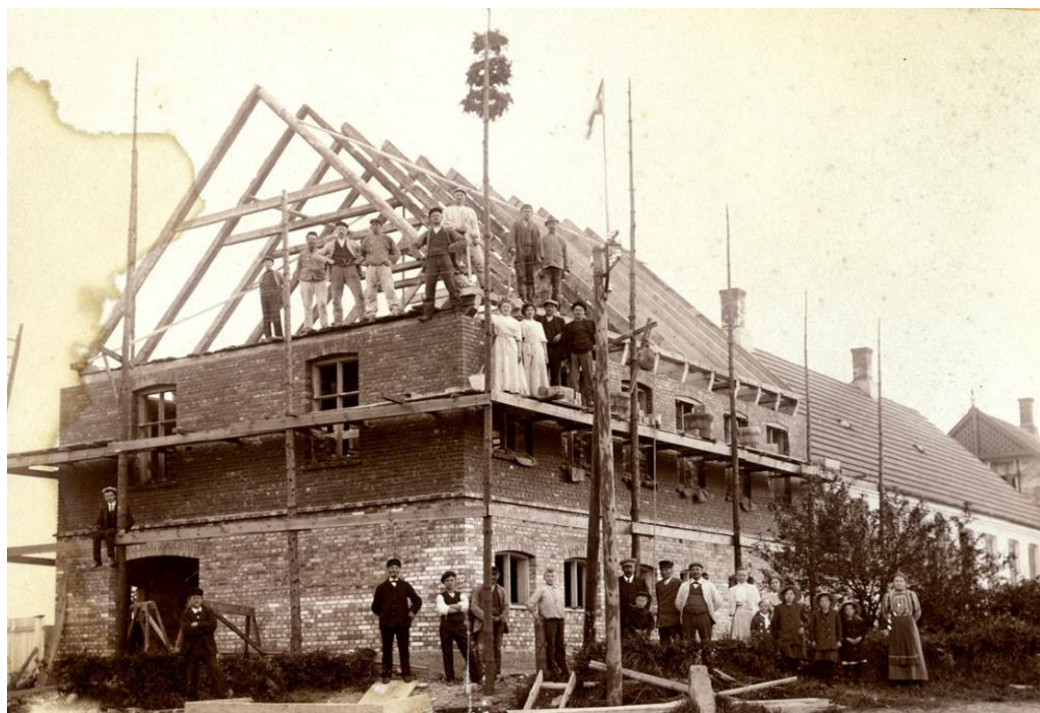
Tømmerrejsning på nybygning 1912.
